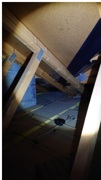
Skader i sutakplater på østside av pipe m.m. Fuktmerker på treverk.
