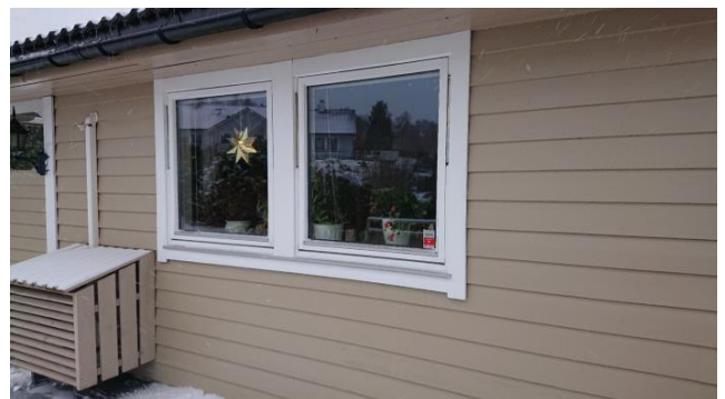
De fleste vinduer i bolighuset er fra bygger 1987.
