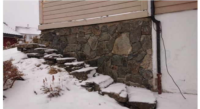
Forstøtningsmur i naturstein til terrasse i sør.
