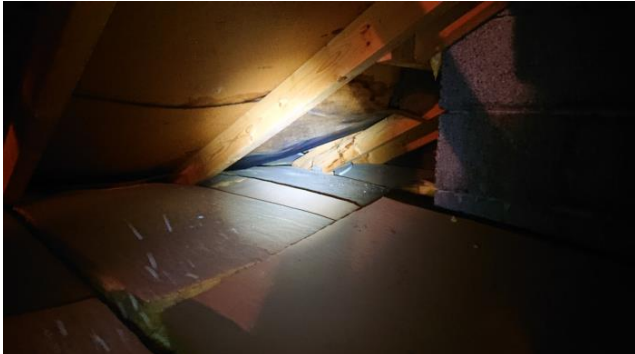
Skader i sutakplater på østside av pipe m.m. Fuktmerker på treverk.
