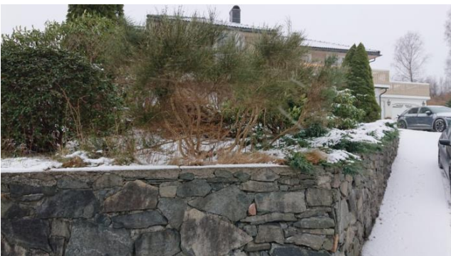
Naturstein forstøtningsmur mot kommunal veg og oppkjørsel.
